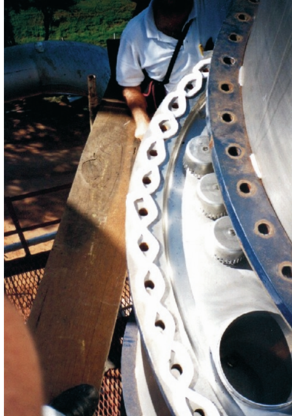
Instalação do produto.
